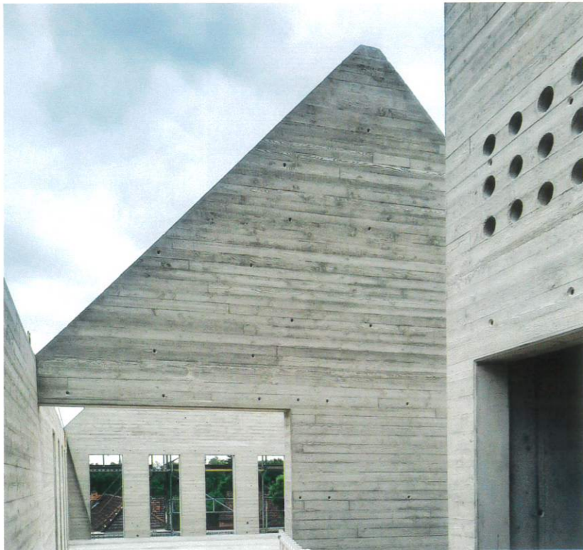
Mit unterschiedlichen Werkzeugen wurden die Texturen für die Oberflächen des Recyclingbetons vorab getestet.
